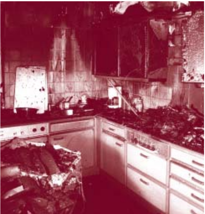
Ein Albtraum: die Küche ist völlig ausgebrannt.
